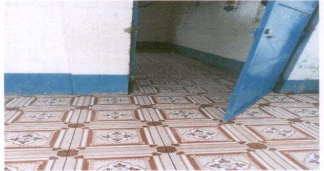
Foto 2: Sustitución de piso de cemento por piso de ceramico (modulo 2) (aula 1)
