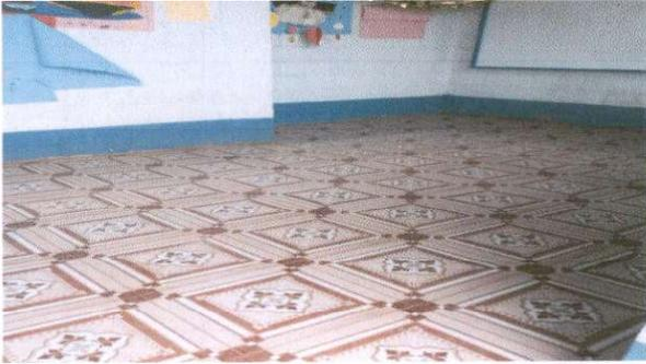
Foto 1: Sustitución de piso de cemento por piso de ceramico (modulo 1) (aula 1)
