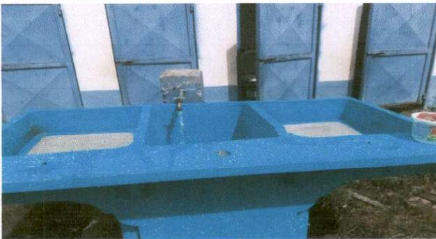
Foto 5: Sustitución de pila de cemento (modulo 1 y modulo 2)
